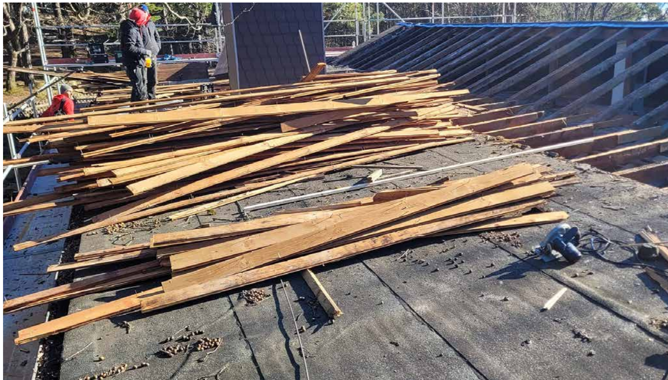
Das Dach wird erst einmal von jahrzehntealten Bitumenbahnen „befreit“. Foto: Thomas Kilian
