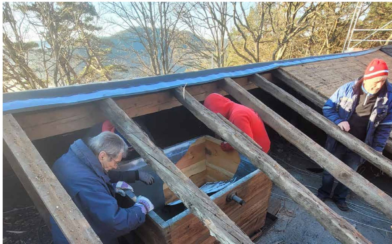
Das Dach wird freigelegt – das Wetter spielte meistens mit. Foto: Thomas Kilian
